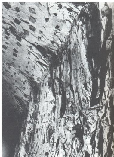
FIG. 1.14 – Ecaillage des parois du tunnel du Mont-Blanc lors de sa construction. Remarquer la forte densité de boulonnage.
