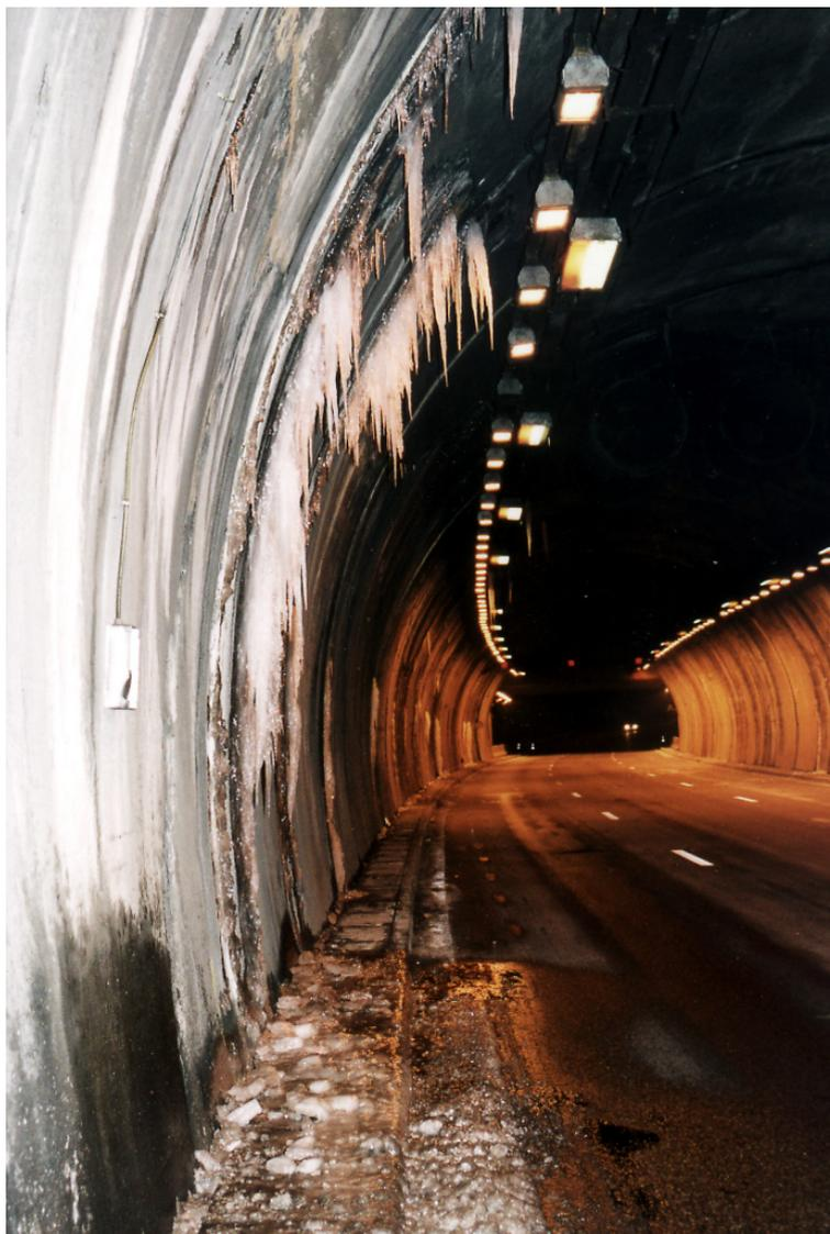
FIG. 1.17 – Stalactites de glace dans le tunnel des Monts en 2002, montrant la présence de défauts dans l'étanchéité du tunnel (Doc. Cetu). Ce tunnel a fait l'objet d'une rénovation lourde en 2005.
