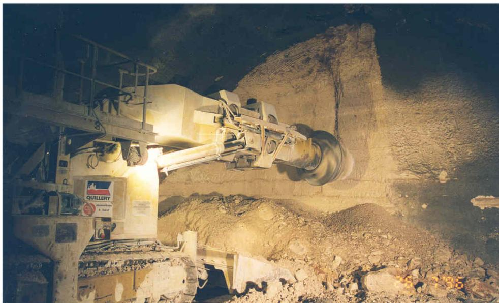
FIG. 1.5 – Machine à attaque ponctuelle sur le tunnel de Tartaguille.
