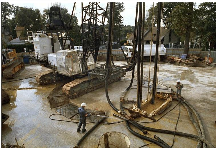
FIG. 1.15 – Creusement de parois moulées avant l'excavation du puits de la Place Berthet sur le chantier de l'A86 (Doc. Socatop 2001)
