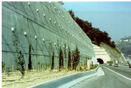
Figure 24: Exemple de mur cloué
