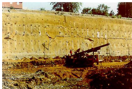
Figure 28: Forage du sol avant introduction des clous
