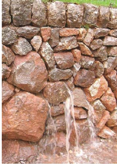
Figure 4: Ecoulement des eaux pluviales à travers un mur en pierres sèches
