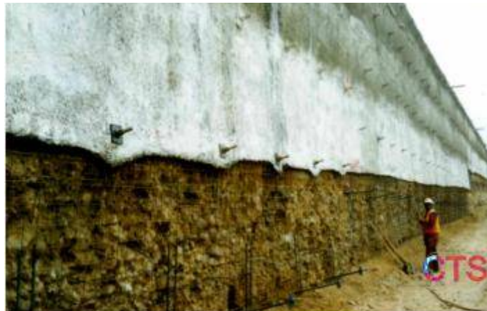
Figure 27: Mise en place du parement en béton par projection
