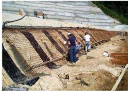
Figure 26: Mise en place des treillis soudés
