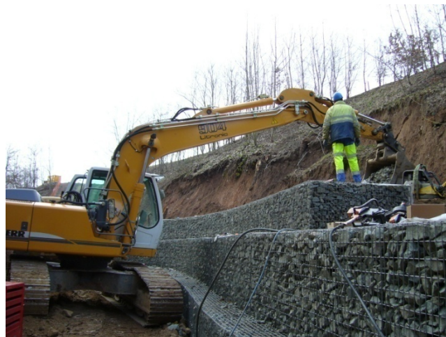
Figure 18: Tractopelle remplissant les gabions
