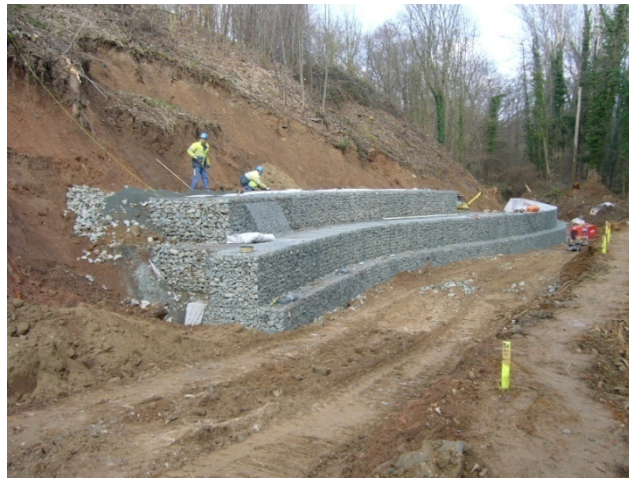
Figure 12: Chantier en cours de réalisation utilisant la technique gabion
