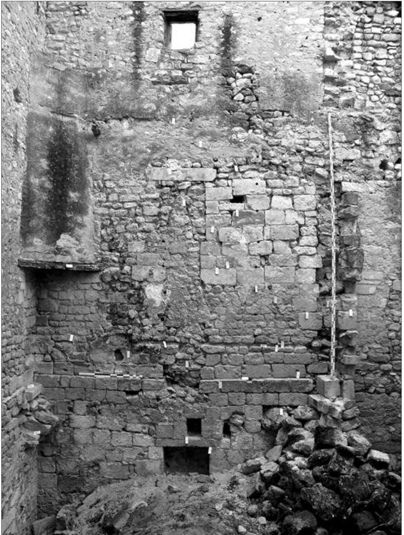
Fig.34 Mur pignon sud (M21) du second bâtiment médiéval (gothique), construit en appui contre l'édifice antérieur (romain). Crédits : Chantal Delomier (Inrap)
