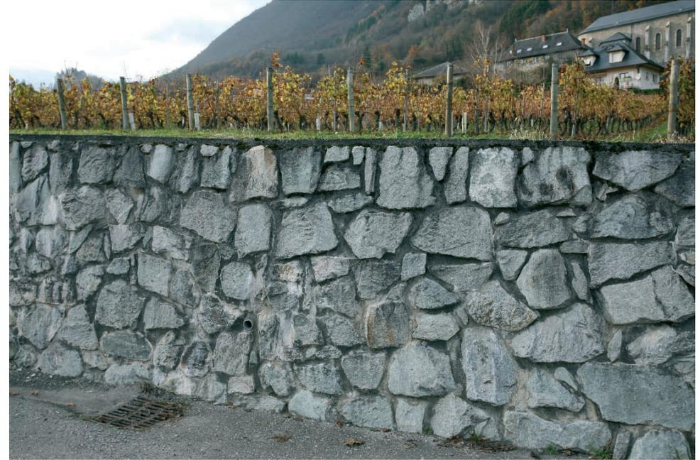
Mur poids en béton de ciment et pierres, étanche. (Frèterive)
