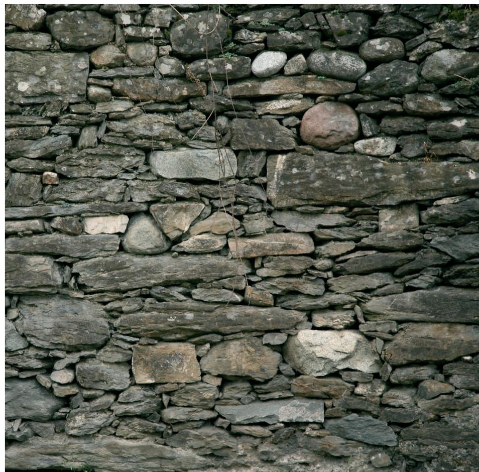
Détail d'un mur de pierre sèche à La Rochette bâti avec des matériaux divers : granites et roches vertes des moraines, calcaires schisteux, galets
