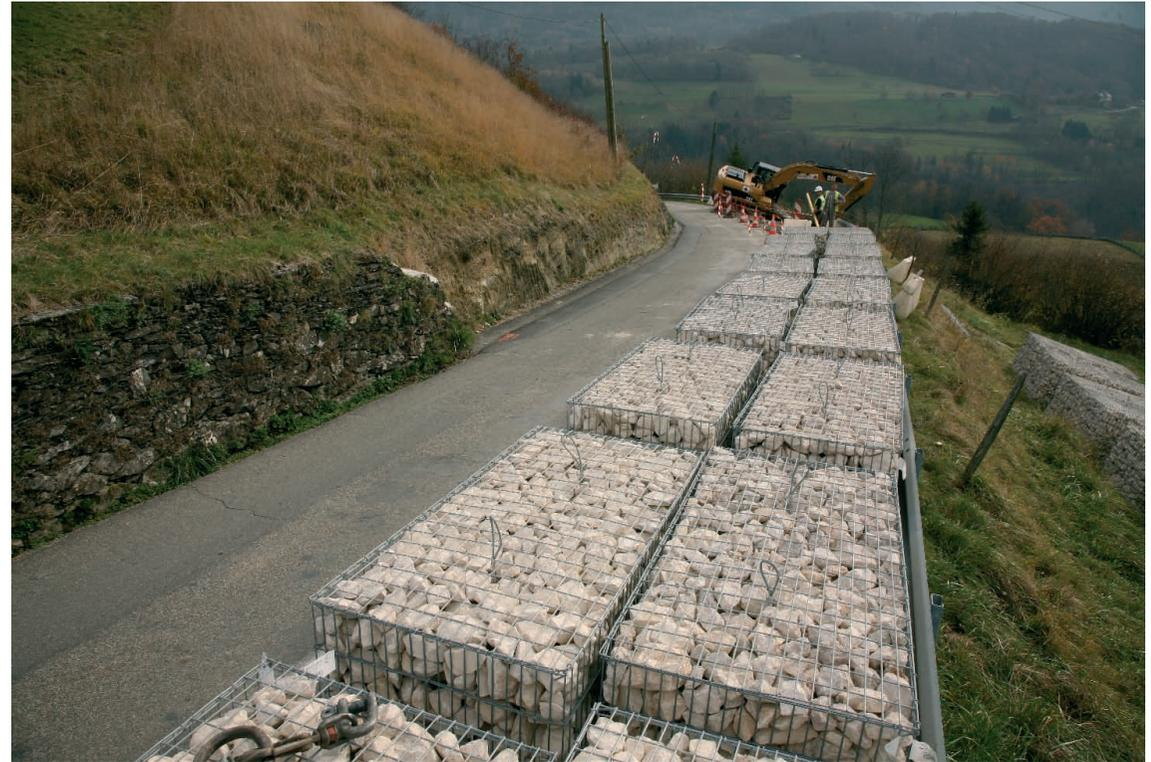
Mise en œuvre de gabions pré-remplis à Etable, au cœur d'un paysage structuré par des murs en pierre sèche...
