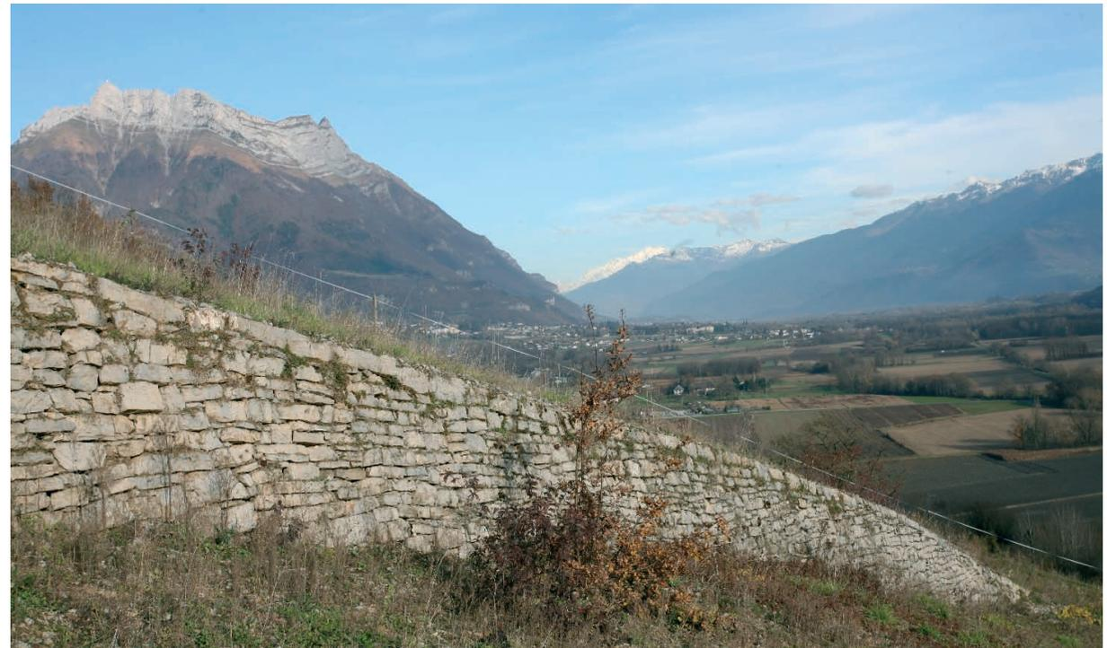
Un exemple de mur rampant : les assises restent horizontales.
