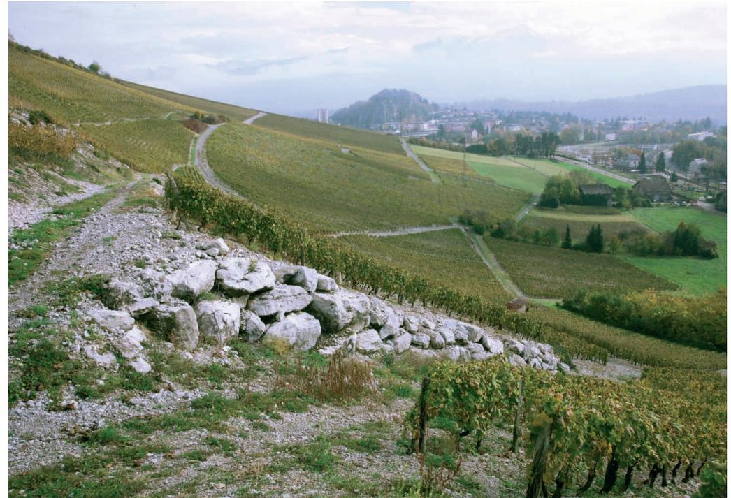
Mur poids de type «blocs secs». Les techniques d'enrochement peuvent s'apparenter à la pierre sèche, avec cependant des réserves quant à leur usage : intégration paysagère difficile, nécessité d'une haute qualité d'agencement pour une vraie stabilité, gros moyens à mettre en œuvre.
